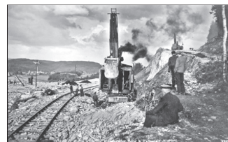
Während der umfassenden Hangabtragung im Jahr 1931 am wandernden Berg zwischen Flöha und Falkenau.
