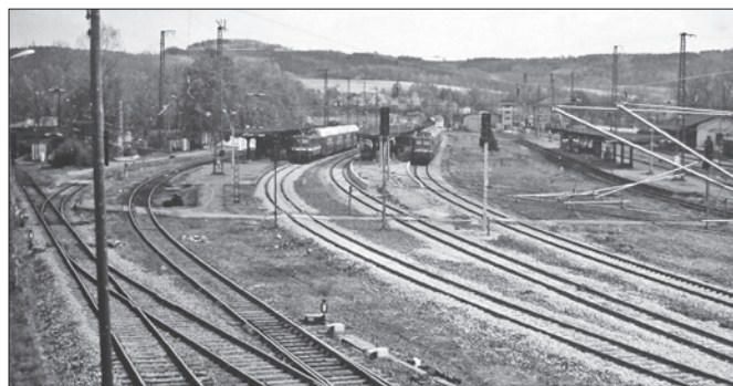
Ein Bild nach der Elektrifizierung der Linie Dresden - Werdau. Gut erkennbar die drei Bahnsteige und der breite gleislose Streifen in der Bildmitte, wo bis 1934 das alte Empfangsgebäude seinen Dienst versah.
